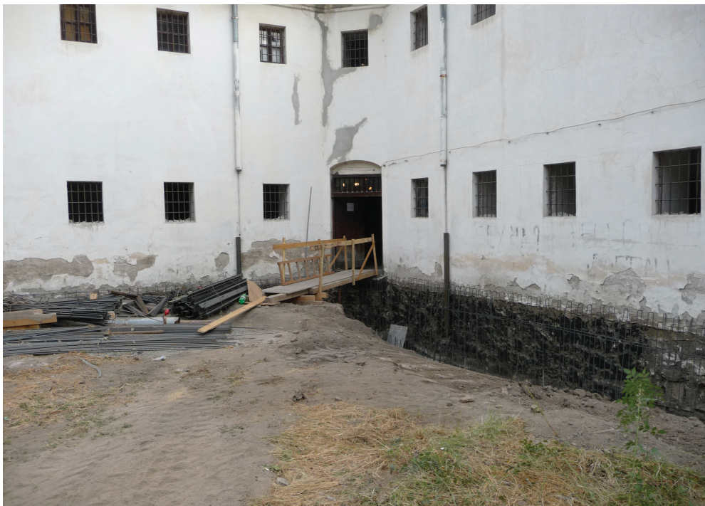
Сн. 2. Ремонт на сградата на „Кръстатата казарма“
