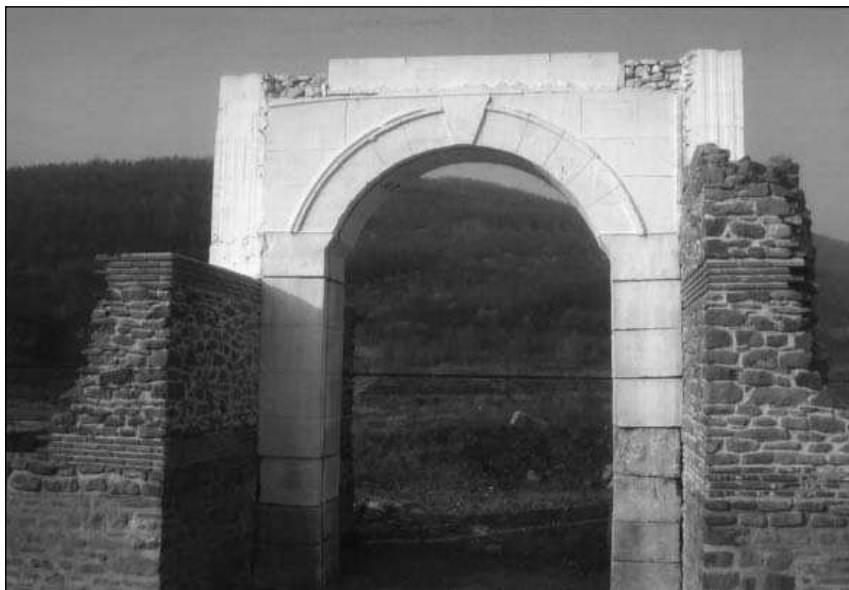
Обр. 7. Главна източна порта на Состра – след реставрация
