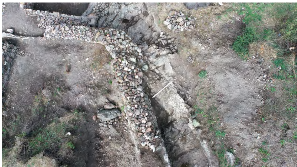
Обр. 41, обр. 42 – Демонтираната част от източната стена на бойна кула 2, ос- танките от нея
