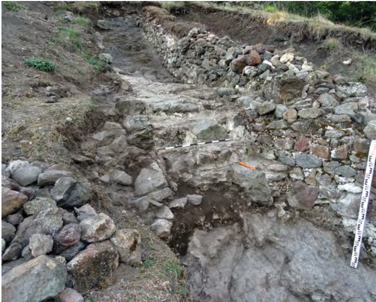
Обр. 45 – Вдясно: изправената стена на бойна кула 2 от края на XIII в, източно лице
