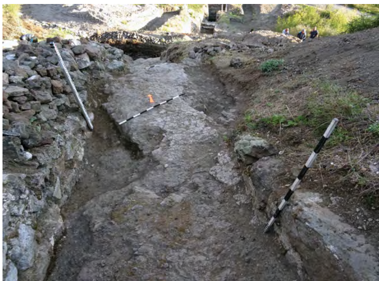
Обр. 40 – Демонтираната част от източната стена на бойна кула 2, останките от нея Fig. 40 – Dismantled part of eastern wall of battle tower 2, remains of it
