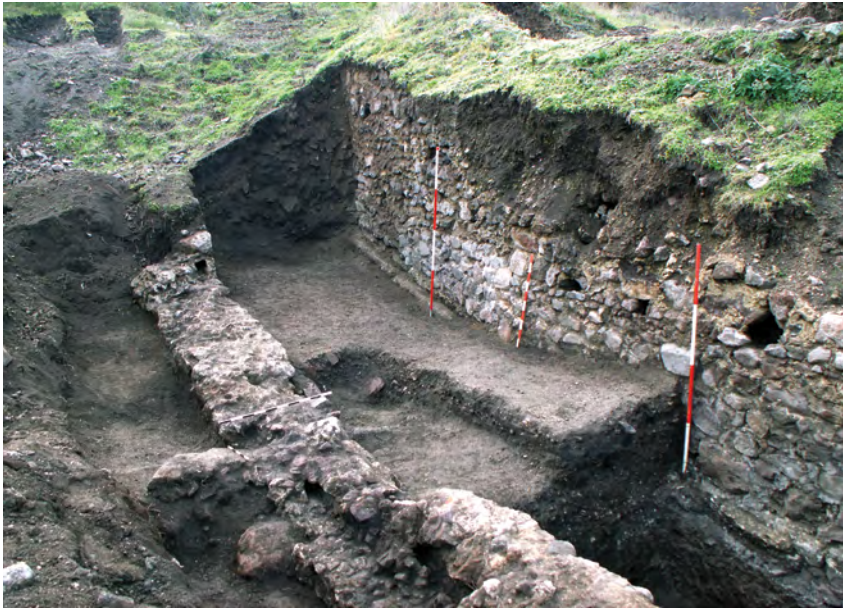
Обр. 15 – Вляво: надлъжни скрити сантрачи в източната стена на прохода, вътрешно лице Fig. 15 – Left: longitudinal hidden beams in the eastern wall of the passage, interior face
