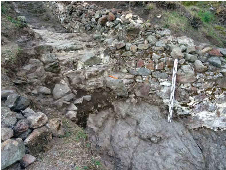
Обр. 48 – Зидани стъпала между вътрешното лице на източната стена на прохода и източната стена на бойна кула 2
