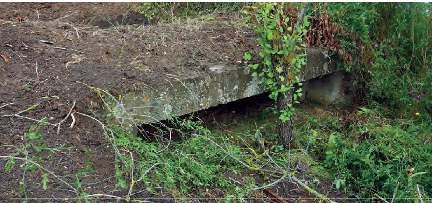
I.1.4. Запазен военен бункер на нос Чироза Preserved military bunker on Cape Chiroza
