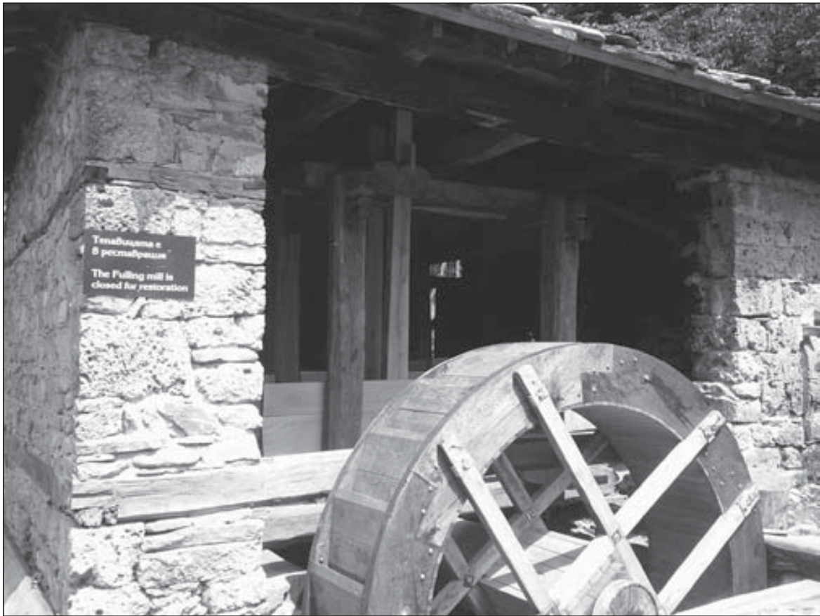
Ремонт на Тепавица – 2006 г.
