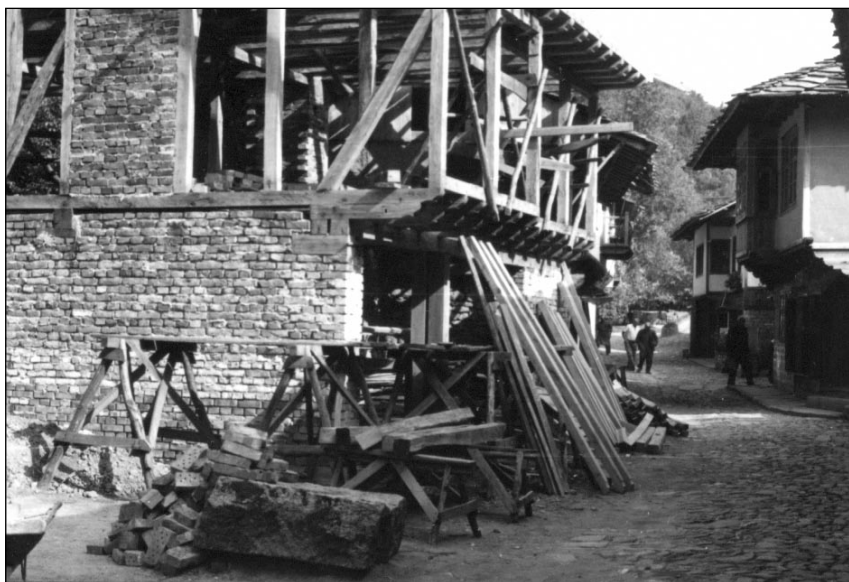
Строеж на Бъчварска работилница
