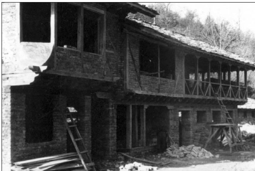
Изграждане на Табахана, Грънчарска и Кюумджийска работилници – 1968 г.
