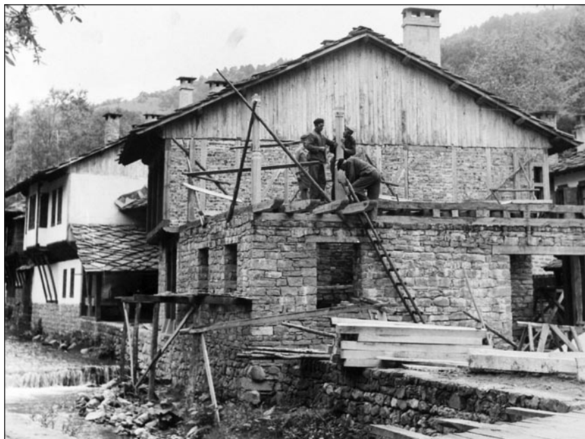
Изграждане на къща от село Гачевци
