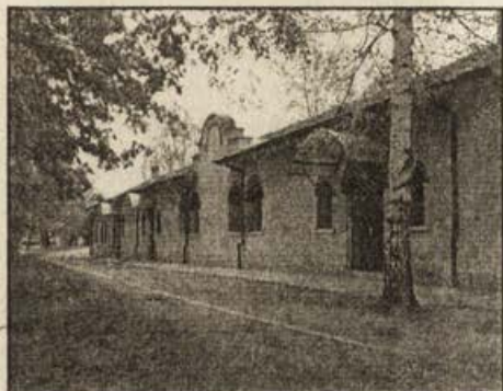
Снимка №1. Външен изглед на обекта (от северозапад).
