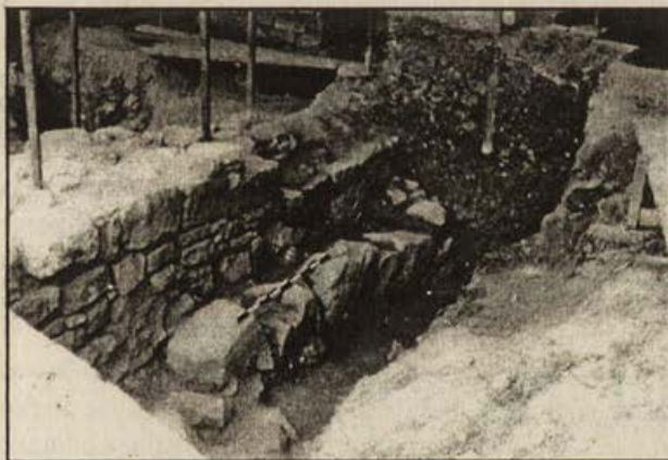
Обр.2. Първи строителен период на източното крило на манастира - останки от субструкцията на западния зид.
