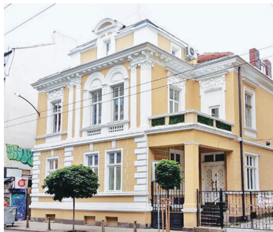
Фиг. 3. Сградата на ул. „Георги С. Раковски“ 167 (Източник: Оглед на място, сн. авт.)
